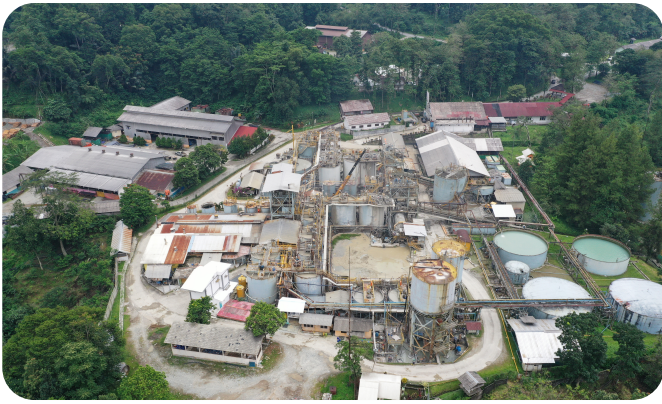
Pabrik Pengolahan Tambang Emas ANTAM Pongkor
